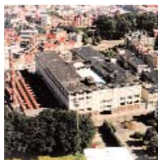
Molenbeek-St-Jean, le bâtiment industriel "Lavoisier" (anciennement British American Tabacco)
